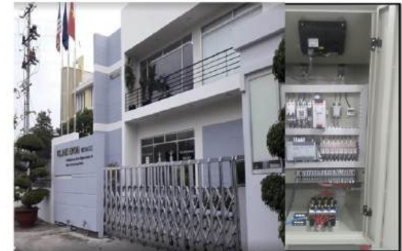
수출 목재 제품 검사 기계용 제어 캐비닛 - 베트남 Williams Sonoma
